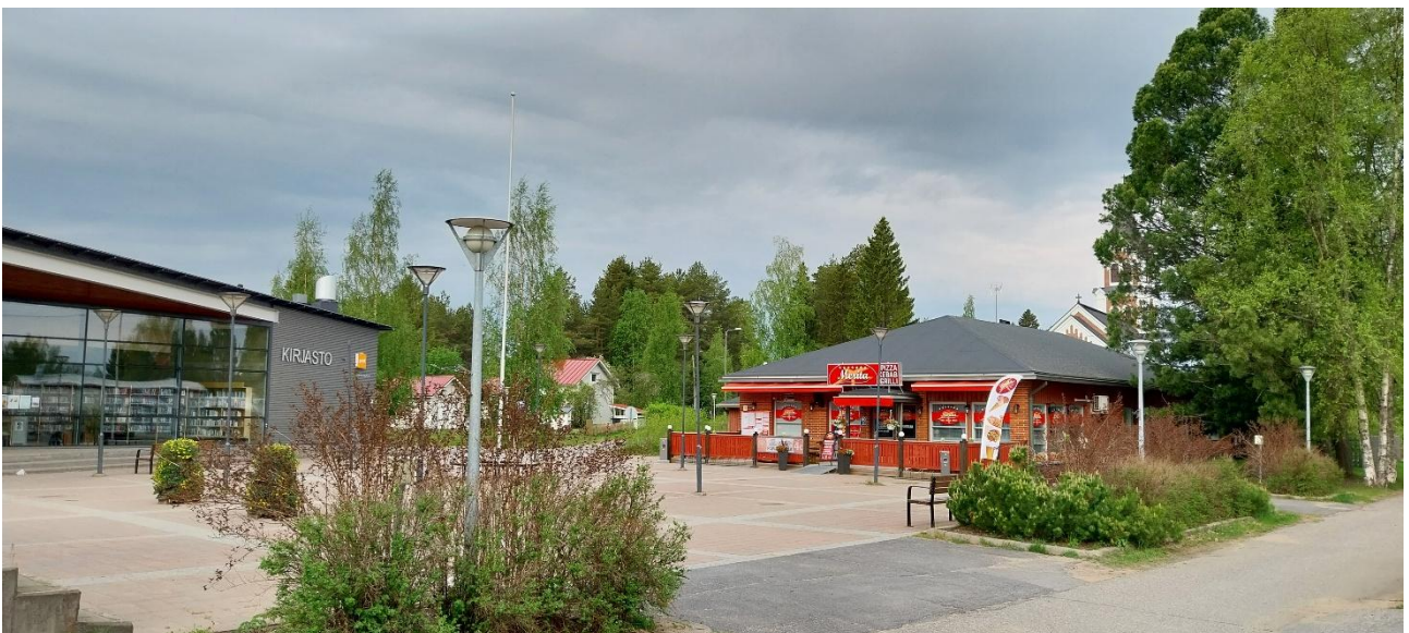
Kuva 7 Vanha Säästöpankin kiinteistö
