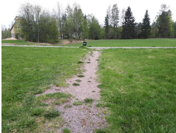
Käytävien lanaus, reunojen teko ja pinnan lisäys
