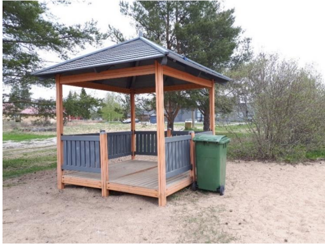
Huvimajan pohjalaudoituksen korjaaminen
