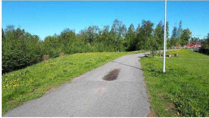
klv:n vasemman laidan raivaus- ja harvennustarpeessa olevaa vesakkoa/puustoa,
