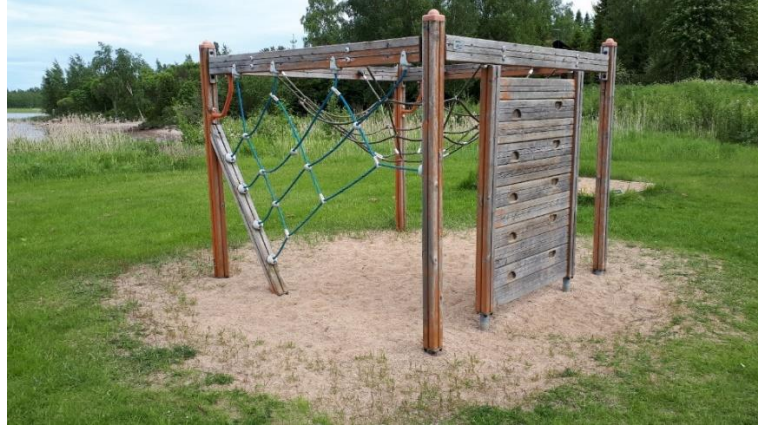
Kiipeilytelineen huoltomaalaus, kiinnikkeiden kiristys ja turva-alueen laajennus riittäväksi
