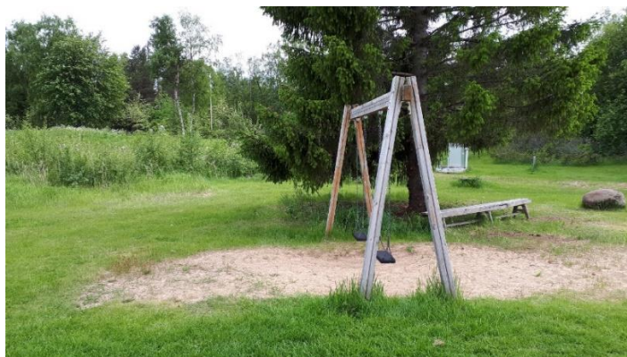
Keinujen runkojen huoltomaalaus, ketjujen/istuinten uusinta ja toinen vaihdetaan vauvaistuimeksi sekä turva-alueet tarkastetaan ja tehdään uusiksi
