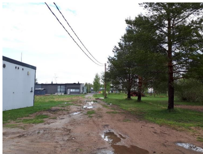
Kunnostettava jalankululle ja polkupyöräilylle varattu kadun osuus
